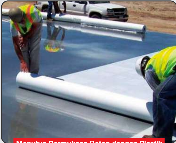
Menutup Permukaan Beton dengan Plastik
