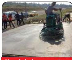
Menghaluskan permukaan dengan mesin trowel
