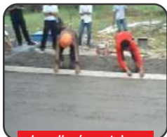
Leveling/meratakan dengan Jidar
