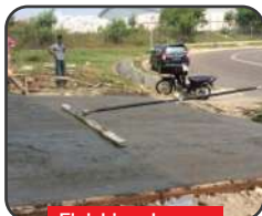
Finishing dengan Bull Floating
