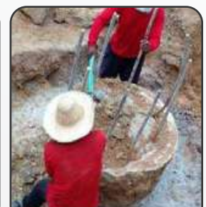
Pemotongan pile head
